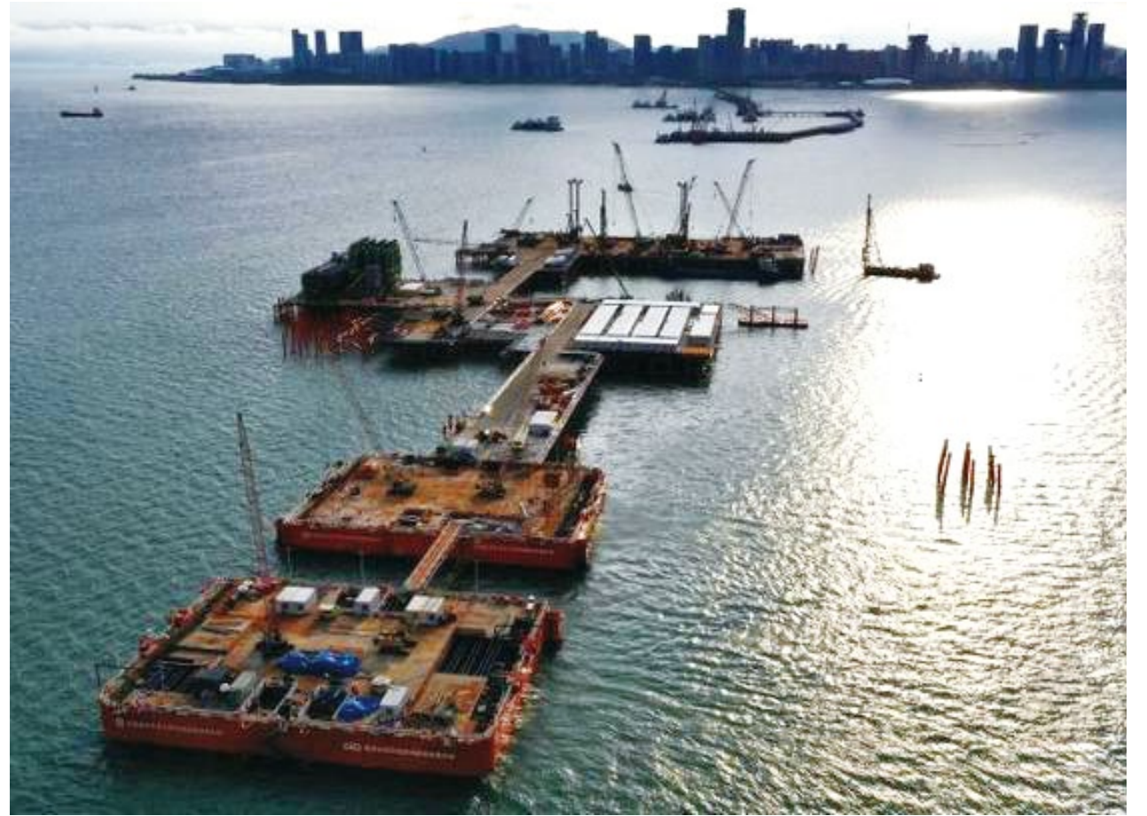
正在建设中的厦金大桥（厦门段）
